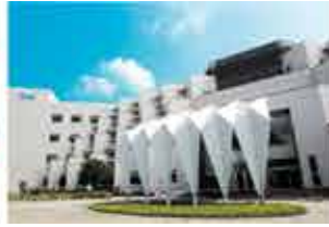
台南研發中心 (鑽石級綠建築)
