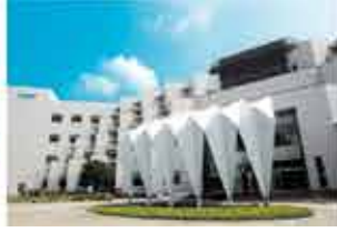
台南研發中心 (鑽石級綠建築)
