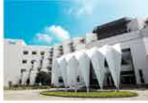
台南研發中心 (鑽石級綠建築)
