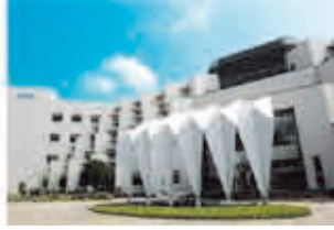
台南研發中心 (鑽石級綠建築)
