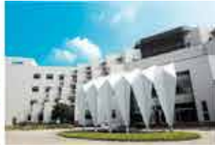
台南研發中心 (鑽石級綠建築)
